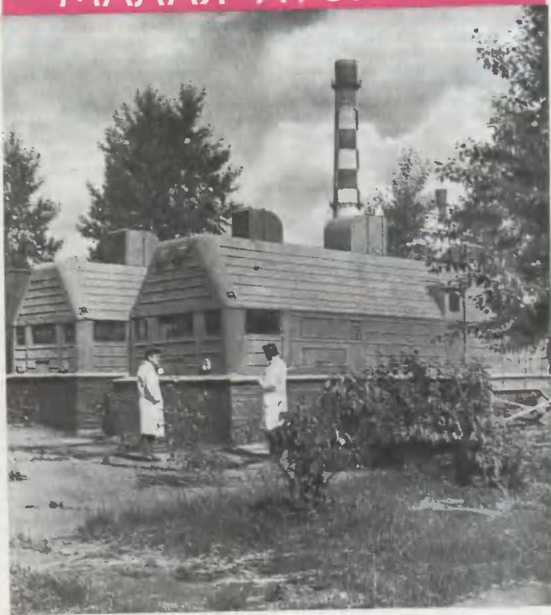
Передвижная АЭС типа ТЭС-3, выполненная размером с железнодорожный вагон.
